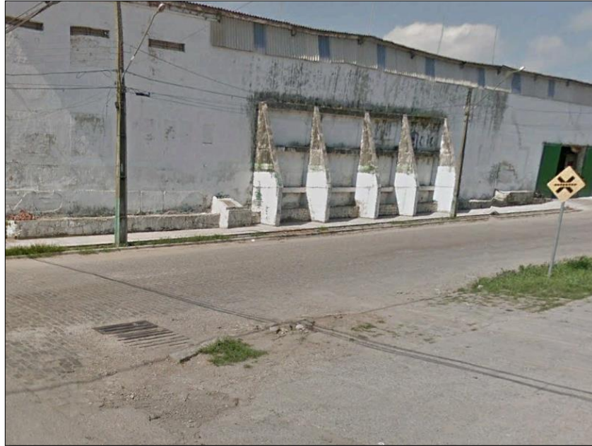
Figura 39: Rede de Drenagem no entorno.
