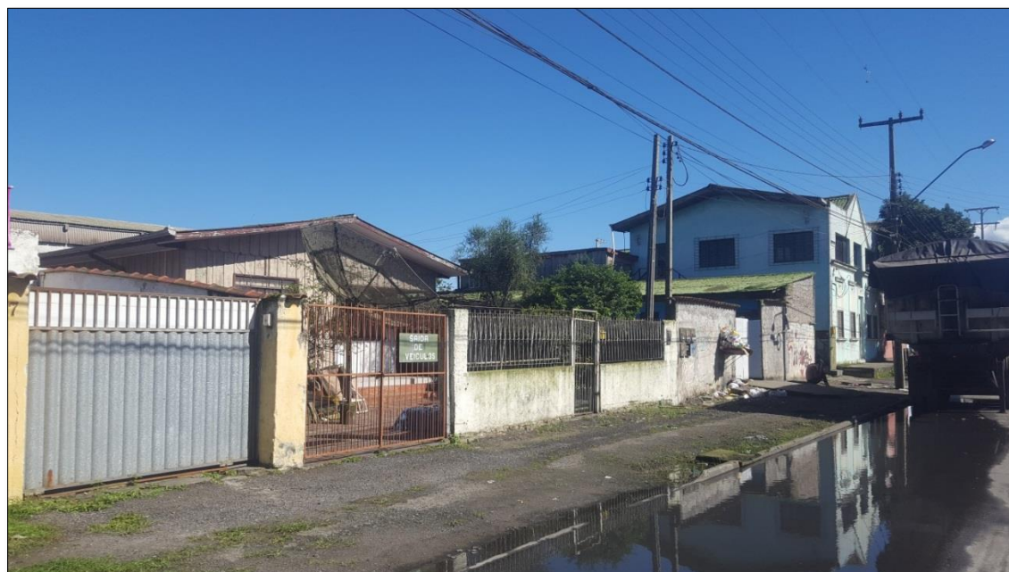
Figura 17: Residências Unifamiliares na Rua Manoel Bonifácio. Fonte: Master Ambiental, 2018.
