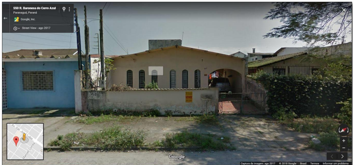
Figura 36: Imóvel na Rua Baronesa do Cerro Azul. Fonte: Google Maps
