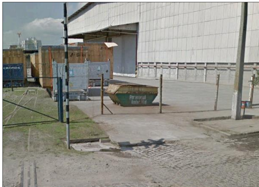
Figura 40: Rede de Drenagem no entorno.
